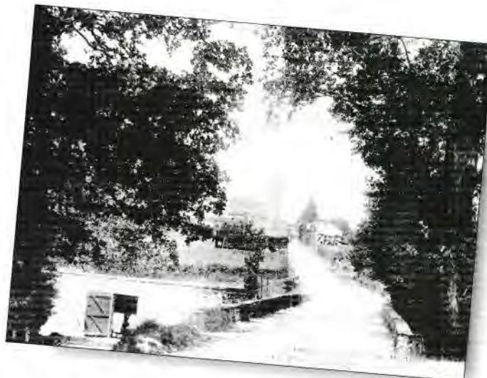
Pont sur le Trézon
