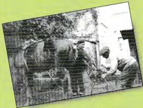
ferrage des sabots du cheval
