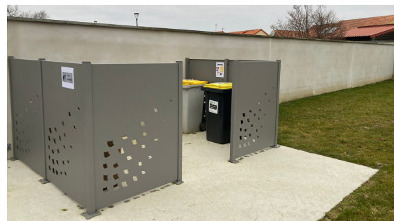
Nouvel aménagement du local poubelles qui est placé à l'entrée du nouveau cimetière.
