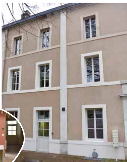
Le bâtiment du 16 rue du Docteur-Coignard a connu un lifting complet pour devenir le centre municipal de santé.
